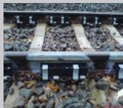
Schienenstegdämpfer
