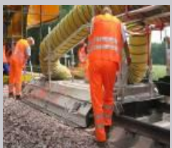
Verschäumtes Schottergleis
