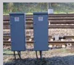
Automatische Schienenschmierung
