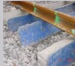
Besohlte Betonschwellen
