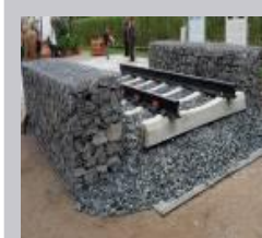
Unterschottermatten m/o Gabionen
