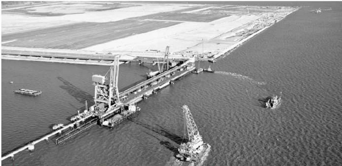
Baustelle Jade-Weser-Port in Wilhelmshaven: Mehr als 43 Millionen Kubikmeter Sand wurden aufgespült, Tragbohlen, Ankerpfähle und Flügelwände in den Schlick gerammt.
