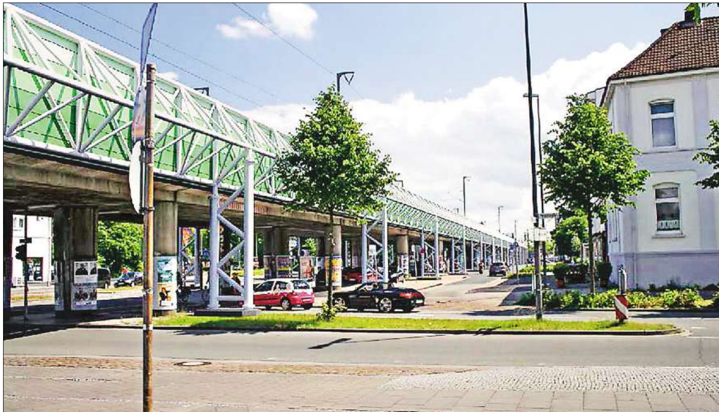
Derzeit noch eine Simulation: Die Eisenbahnbrücke am Pferdemarkt mit Lärmschutzwänden. Die Zukunft aber könnte genau das bringen – wenn die Stadtstrecke ausgebaut wird.
