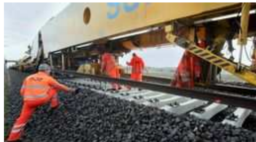
Gleisbauzug verlegt neue Bahnschwellen
