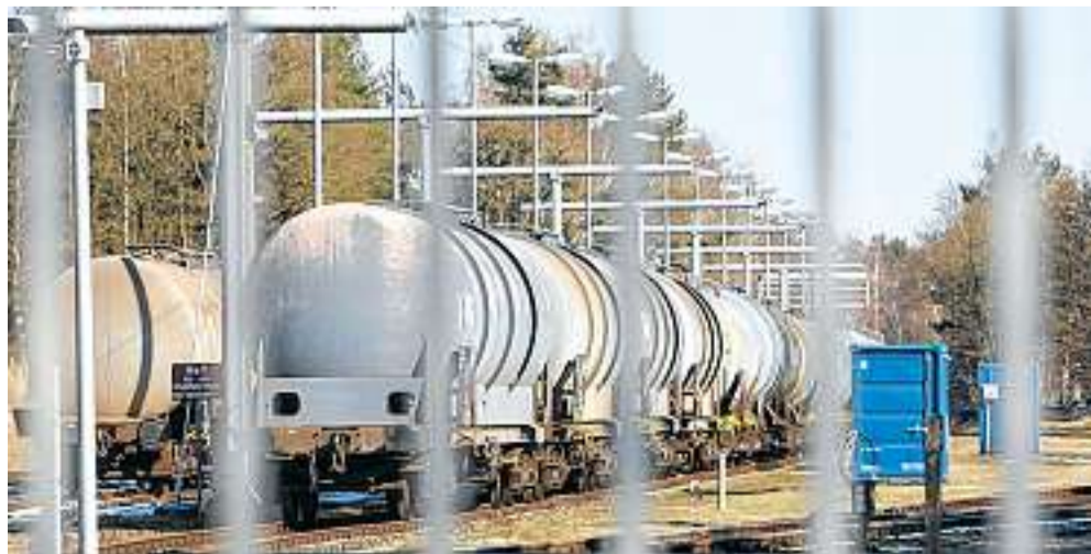
Das Tanklager in Farge: Seit dem vergangenen Sommer reißt der Faden der Negativ-Nachrichten in Zusammenhang mit der Grundwasserverunreinigung nicht ab. FOTO: KOSAK
