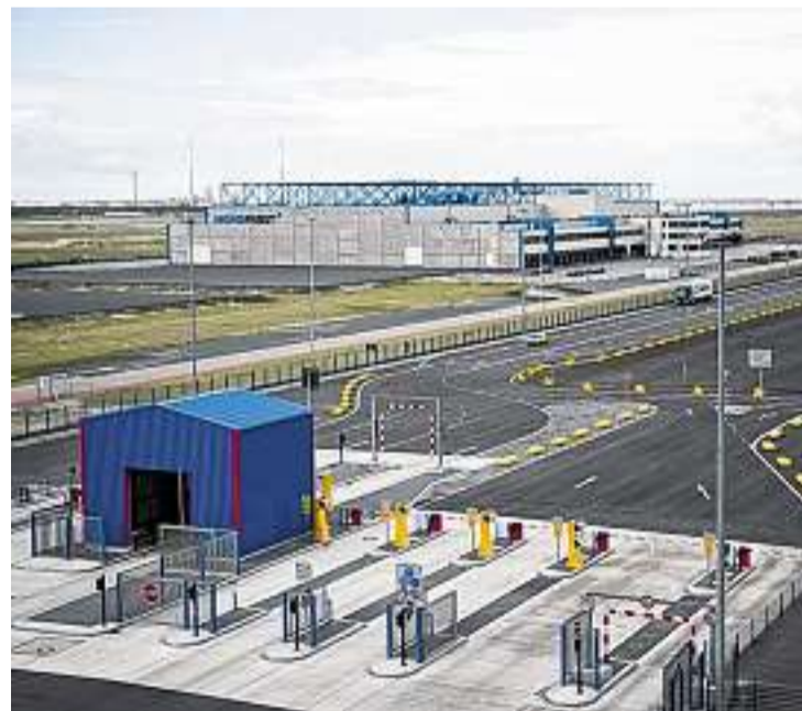
Verwaist: An der hochmodernen Abfertigungsanlage gibt es nur wenig zu tun. FOTO: EUTENEIER
