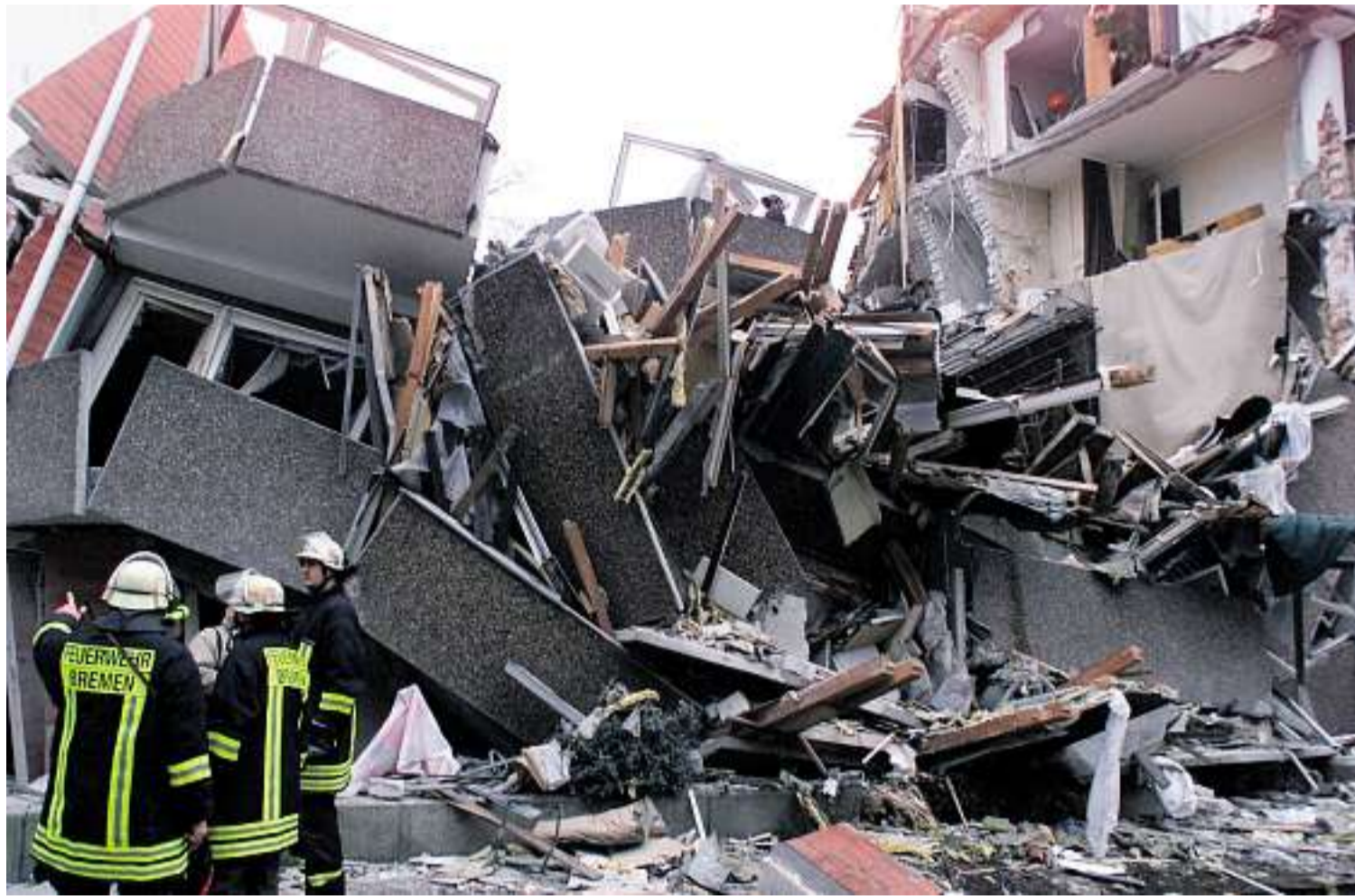
Die letzte Großschadenslage in Bremen liegt 13 Jahre zurück: Am 20. November 2000 zerstörte eine Gasexplosion ein Wohnhaus im Geschwornenweg. Zwölf Menschen starben bei dem Unglück, 84 Stunden dauerte der Einsatz, mehr als 300 Rettungskräfte waren daran beteiligt. FOTOS: KOCH
