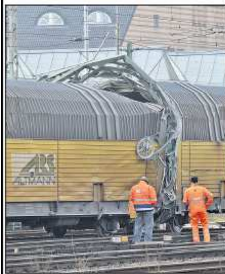
Der entgleiste Waggon riss einige Signalanlagen und Masten am Hauptbahnhof um. Foto: Schlie
