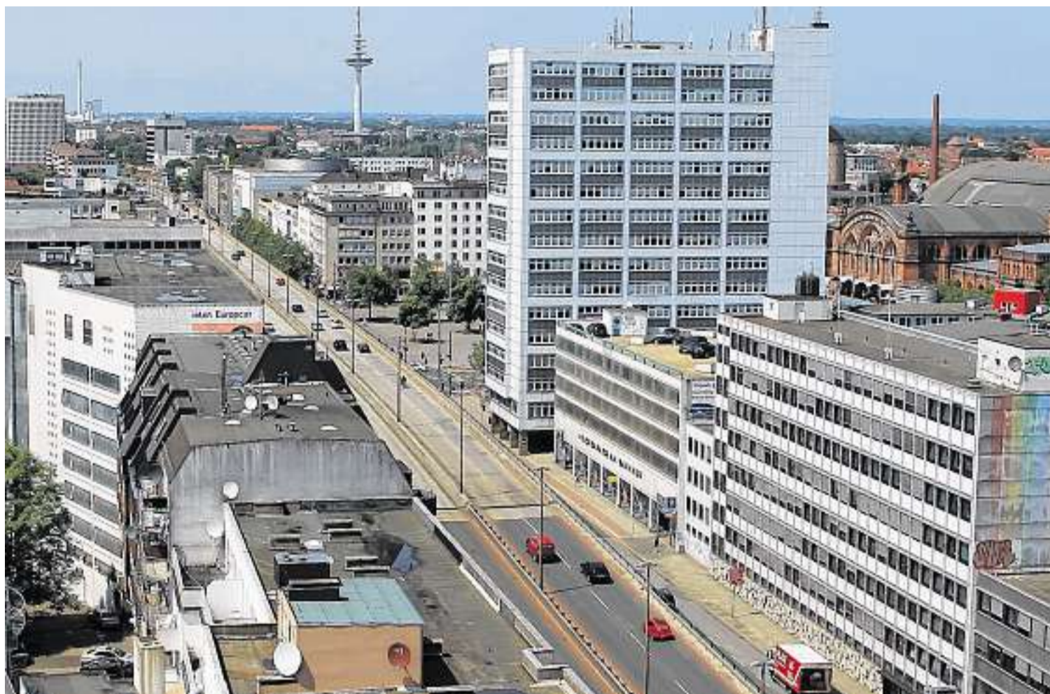
Die Hochstraße Breitenweg wird für den städtischen Verkehr gebraucht – so lautet das Fazit von Gutachtern.
