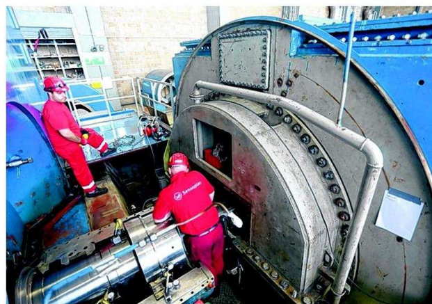
Die Revision soll das Kraftwerk fit machen für die kommenden zehn Jahre. Unter anderem wird das Kraftwerk darauf ausgelegt, die Produktion schnell hoch- und runterfahren zu können. FOTO: KOSAK
