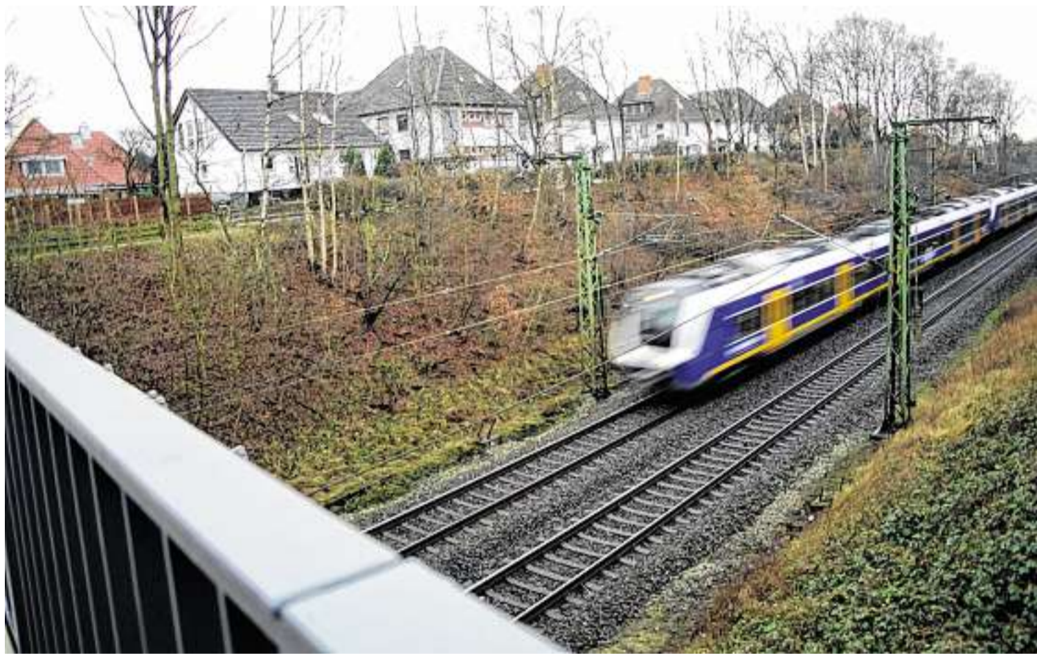
In Ritterhude kommen andere Teile der Bereiche Luisenstraße (Foto) und Auf den Rathen in den Genuss der Lärmschutzwände; bis Juni 2015 sollen die Arbeiten in der Hamme-Gemeinde abgeschlossen sein. FOTO: CHRISTIAN VALEK
