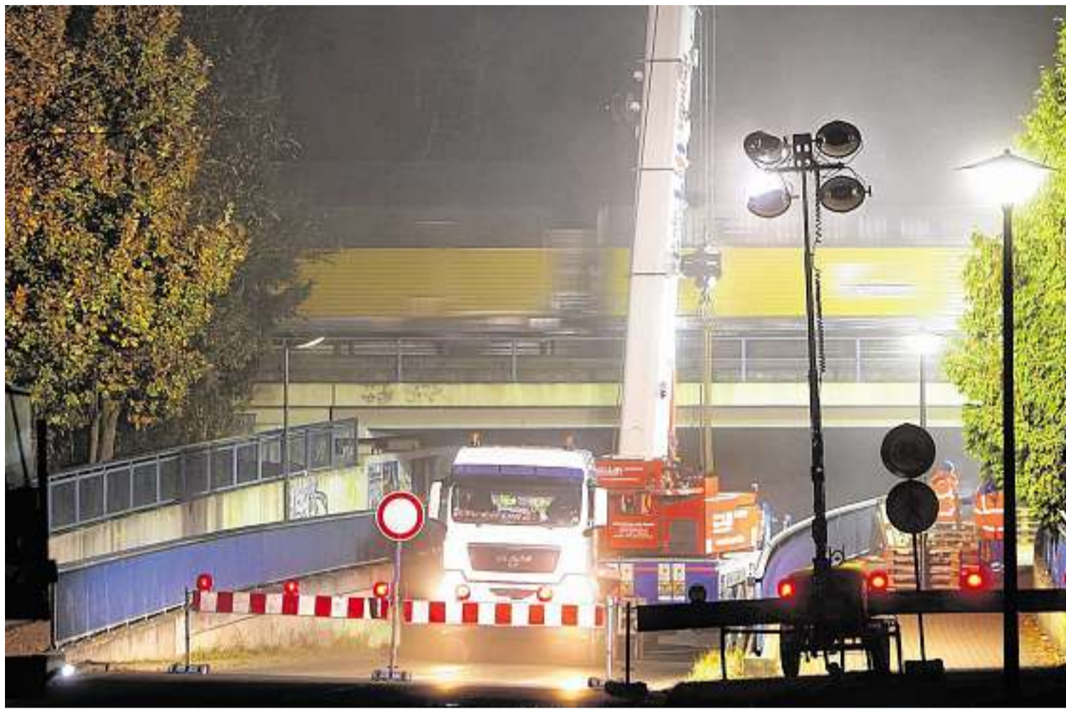
Bei Flutlicht – und während Züge vorbeirauschen – hebt der Kran die Lärmschutz-Elemente an ihren Platz.
