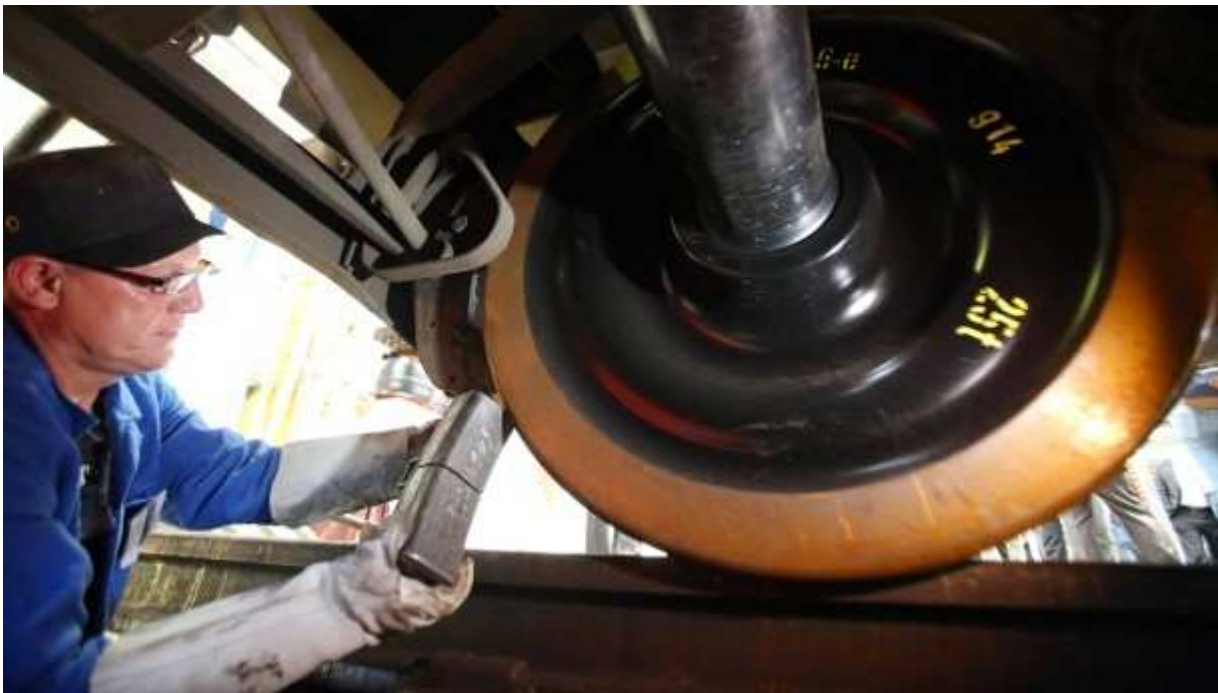
Ein Bahn-Techniker baut einen neuen Bremsklotz ein.
