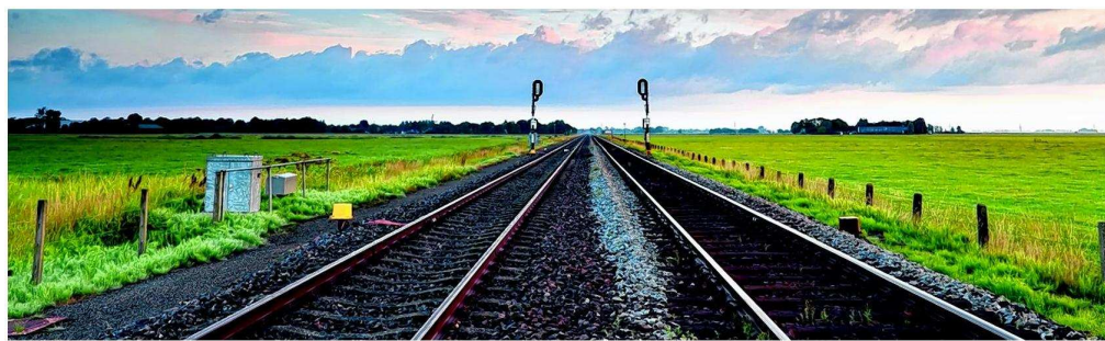
Güterzüge sollen nicht auf der Wunderlinie fahren, denn Niedersachsen will dem Jade-Weser-Port keine Konkurrenz machen.
