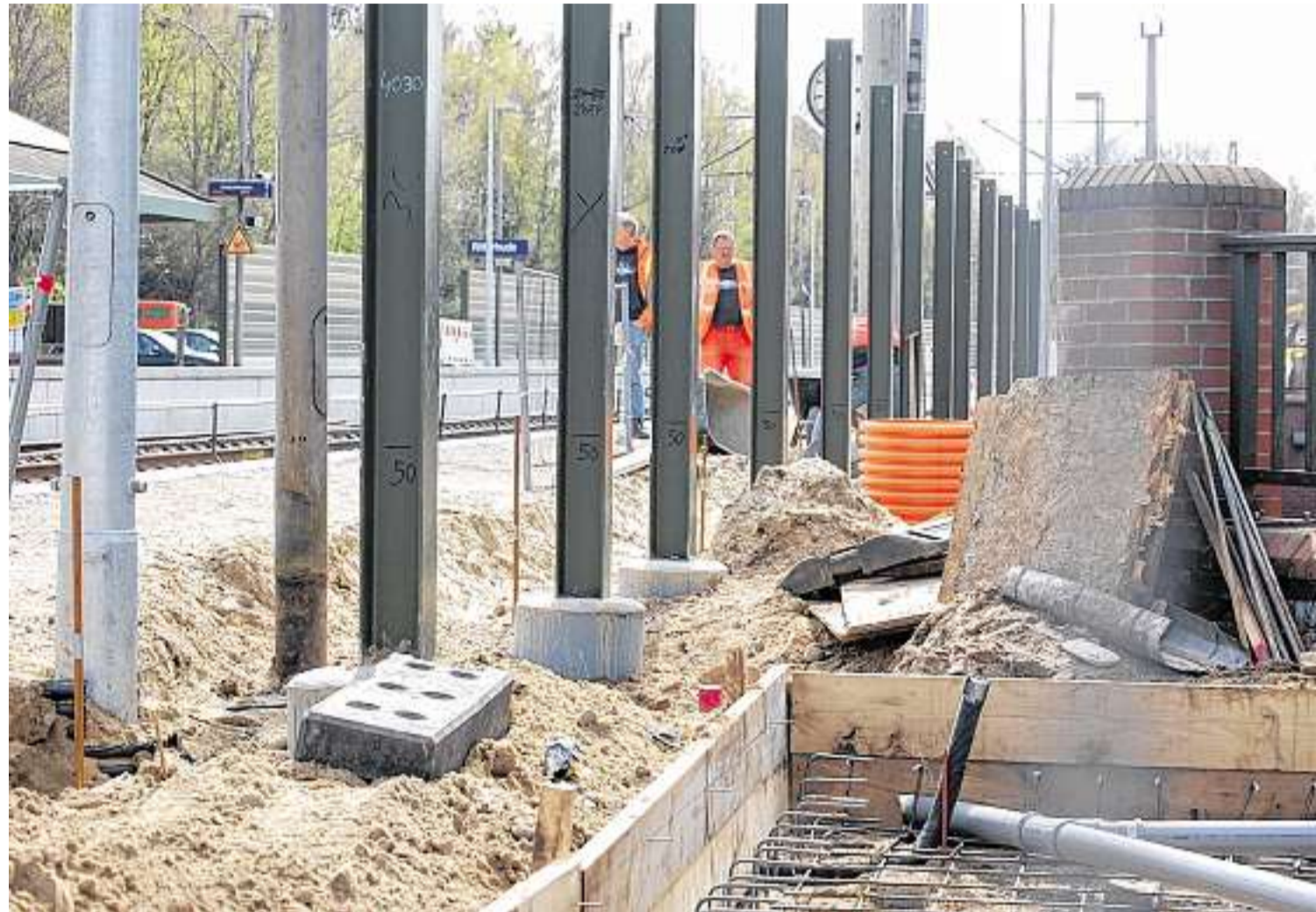
Knapp 3300 Meter Lärmschutzwand lässt die Deutsche Bahn in Ritterhude errichten: Dazu werden in regelmäßigen Abständen Gründungsrohre fünf bis sieben Meter tief in die Erde versenkt, in die die Doppel-T-Träger einbetoniert werden. Gleichzeitig wird der Bahnsteig saniert. FOTOS: LANGE
