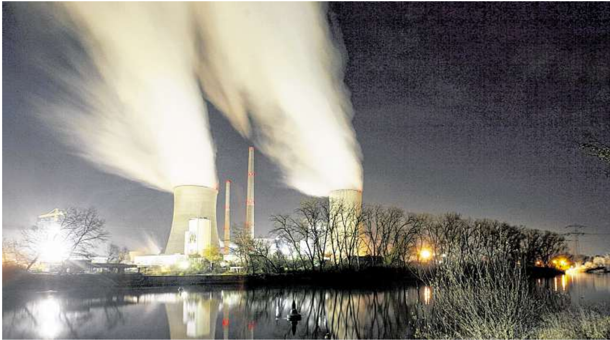
Mehrere Blöcke des von Eon betriebenen Kraftwerks Staudinger bei Großkrotzenburg (Hessen) wurden bereits stillgelegt. Im Regelbetrieb ist nur noch der mit Steinkohle betriebene Block 5. FOTO: DPA
