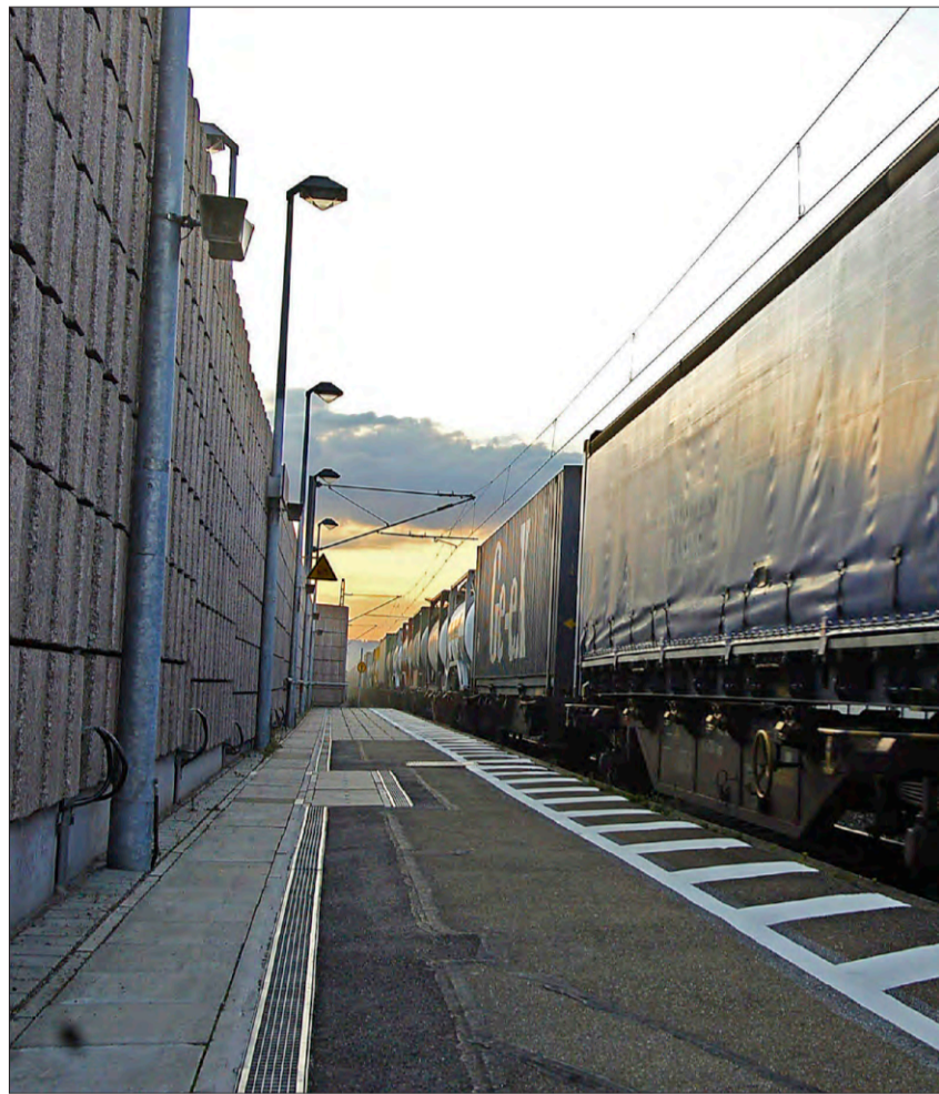
Wie viel Lärmschutz muss an einer Bahnstrecke sein? Darüber wird am Oberrhein heftig debattiert. Unser Bild zeigt Eimeldingen FOTO: LANGELOTT
