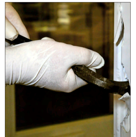
Nicht einsehbare Fenster empfehlen Häuser als geeignete Objekte für einen Einbruch.
