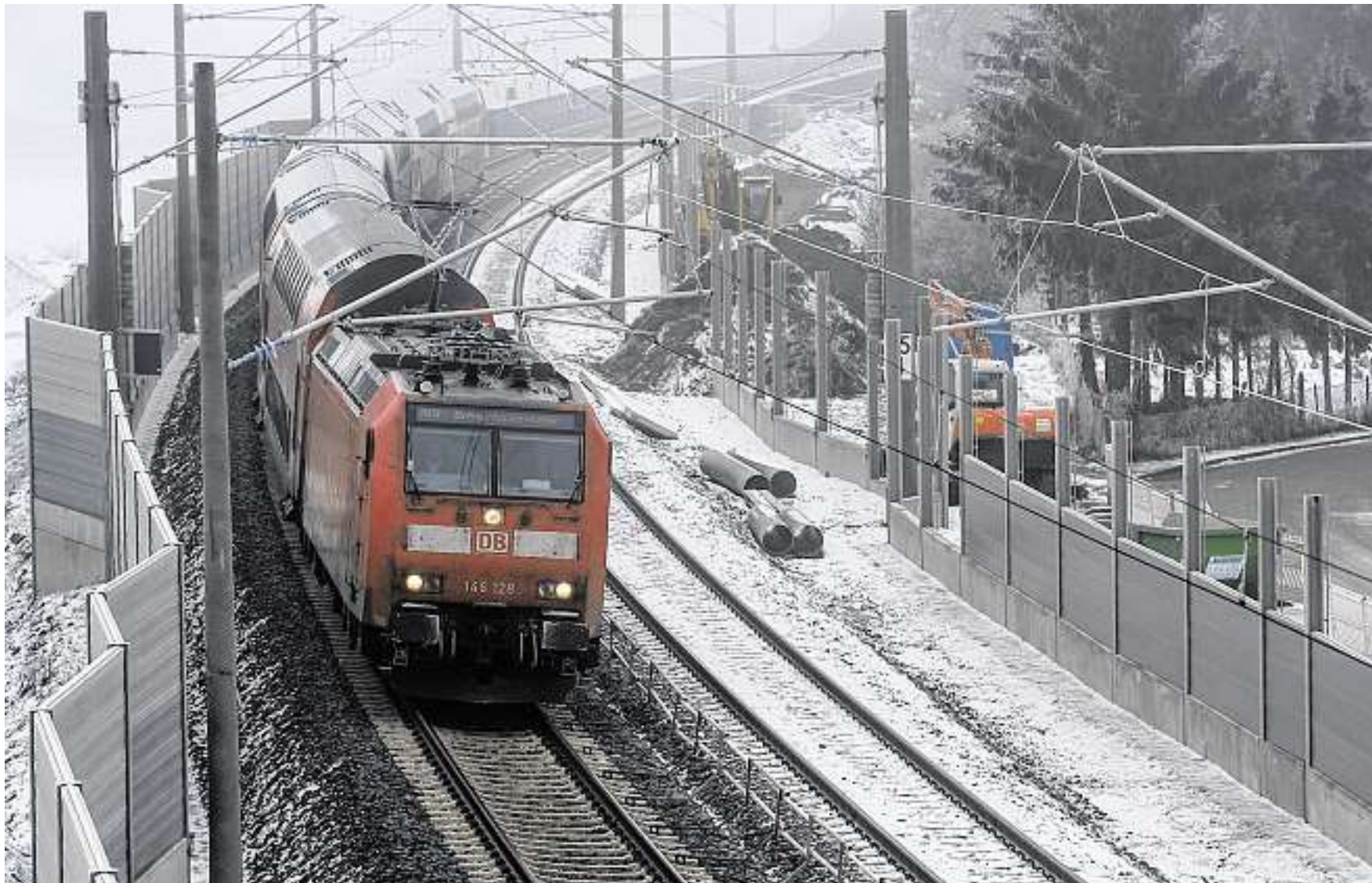
Die Vorarbeiten am Lärmschutz haben in Verden begonnen: In der Kernstadt-Süd werden Schallschutzwände ab Februar 2016 errichtet. Der nördliche Bereich vom Bahnhof bis zum Grünen Jäger ist im nächsten Jahr an der Reihe. FOTO: HAKE
