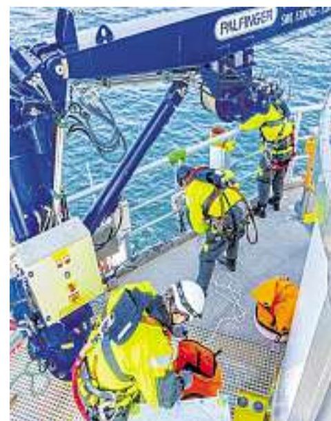
Ein Team der Deutschen Windtechnik bei Arbeiten im Offshore-Windpark Dan Tysk. FOTO: FR
