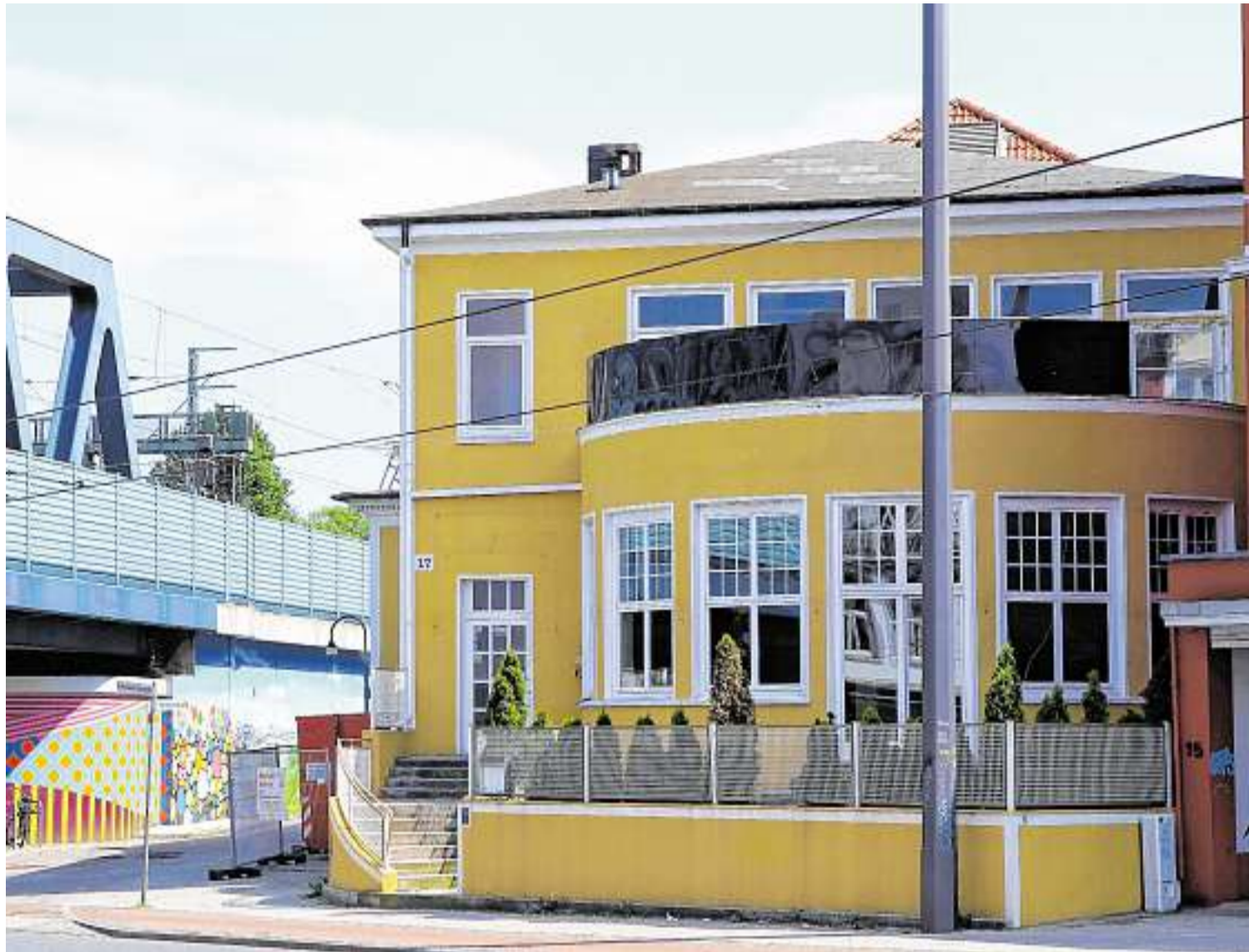
Der Abriss droht: Das Concordia-Theater soll einem studentischen Wohnheim weichen.
