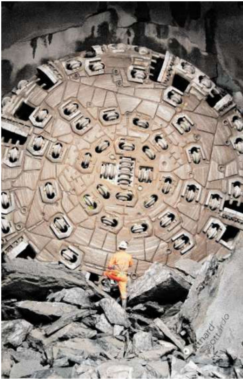
Auf den Namen „Sissi“ hörte die Tunnelbohrmaschine von Herrenknecht, die im Oktober 2010 für den Durchstich im Gotthard-Tunnel sorgte. Jetzt wird das Bauwerk eröffnet. FOTO: DPA
