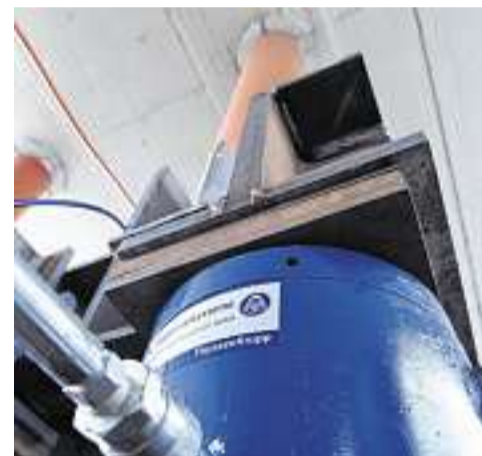
24 Hydraulikpressen sollen die Hochstraße wieder in Nulllage bringen.
