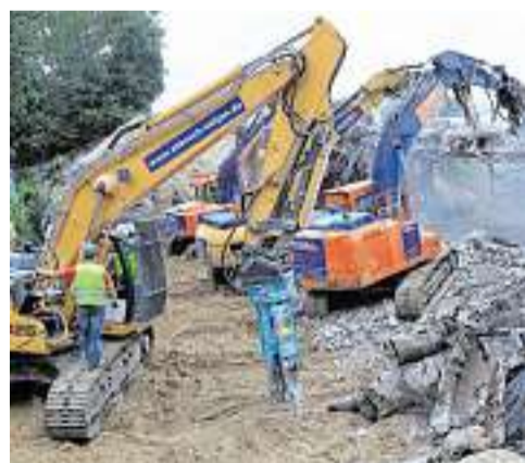
Im Einklang arbeiten die vier Baumaschinen am Abriss.
