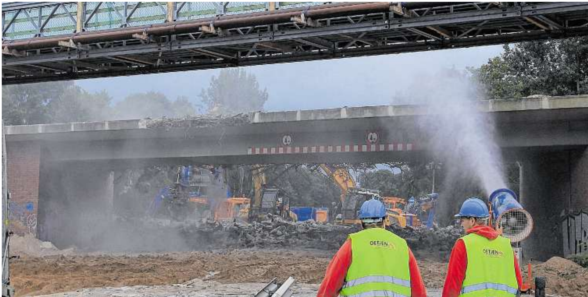
Wie in einer Symphonie arbeiten sich die drei Bagger in das marode Bauwerk der Brücke über der Bundesstraße 75.
