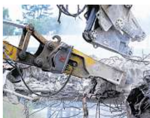
Der tonnenschwere Stemmhammer des Baggers beißt sich in den Beton.
