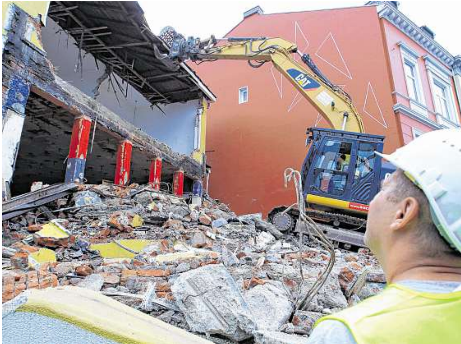
Der Greifer des Baggers frisst sich in die Fassade des Concordia-Theaters. Das Gebäude ist damit Geschichte.
