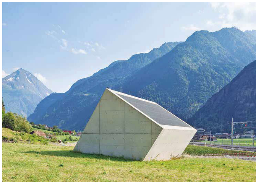
Eine Skulptur moderner Kunst mitten im Heidi-Idyll? Nein, ein Lüftungsschacht für den Gotthardtunnel Foto: Burg+Schuh/Palladium/laif
