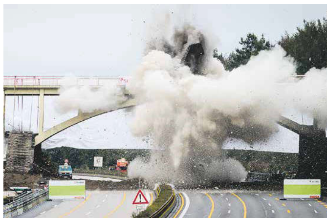
Explosive Wirkung: Sprengung einer Autobahnbrücke Foto: Christoph Schmidt/dpa
