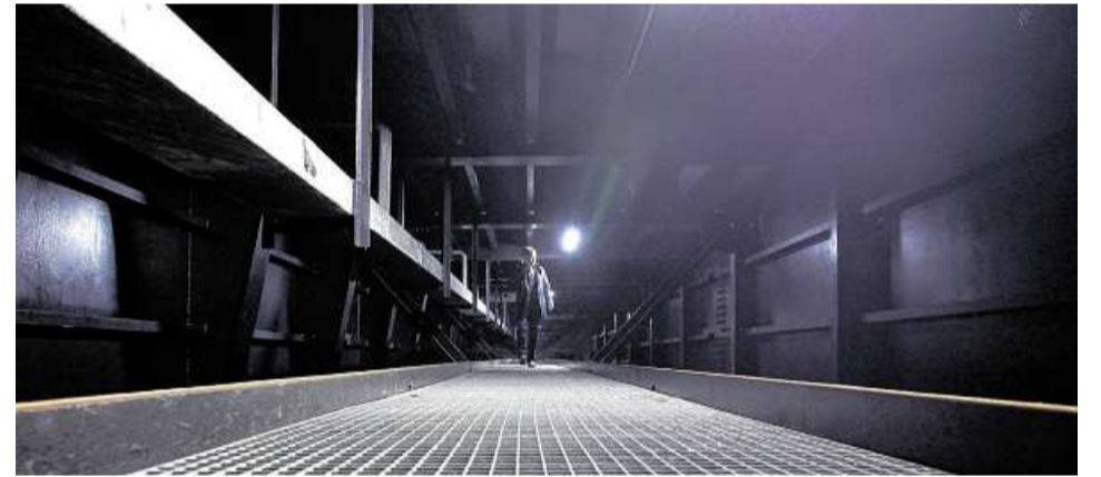
Kontrollgang im Innern der Stephanibrücke.
