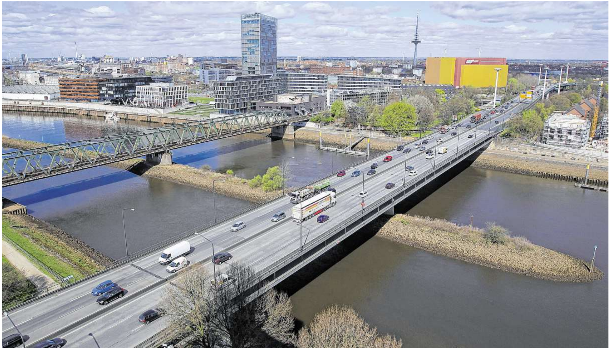
Tausende Autos und Lkw passieren täglich die Stephanibrücke. Das Bauwerk verbindet Bremen-Mitte mit der Neustadt.
