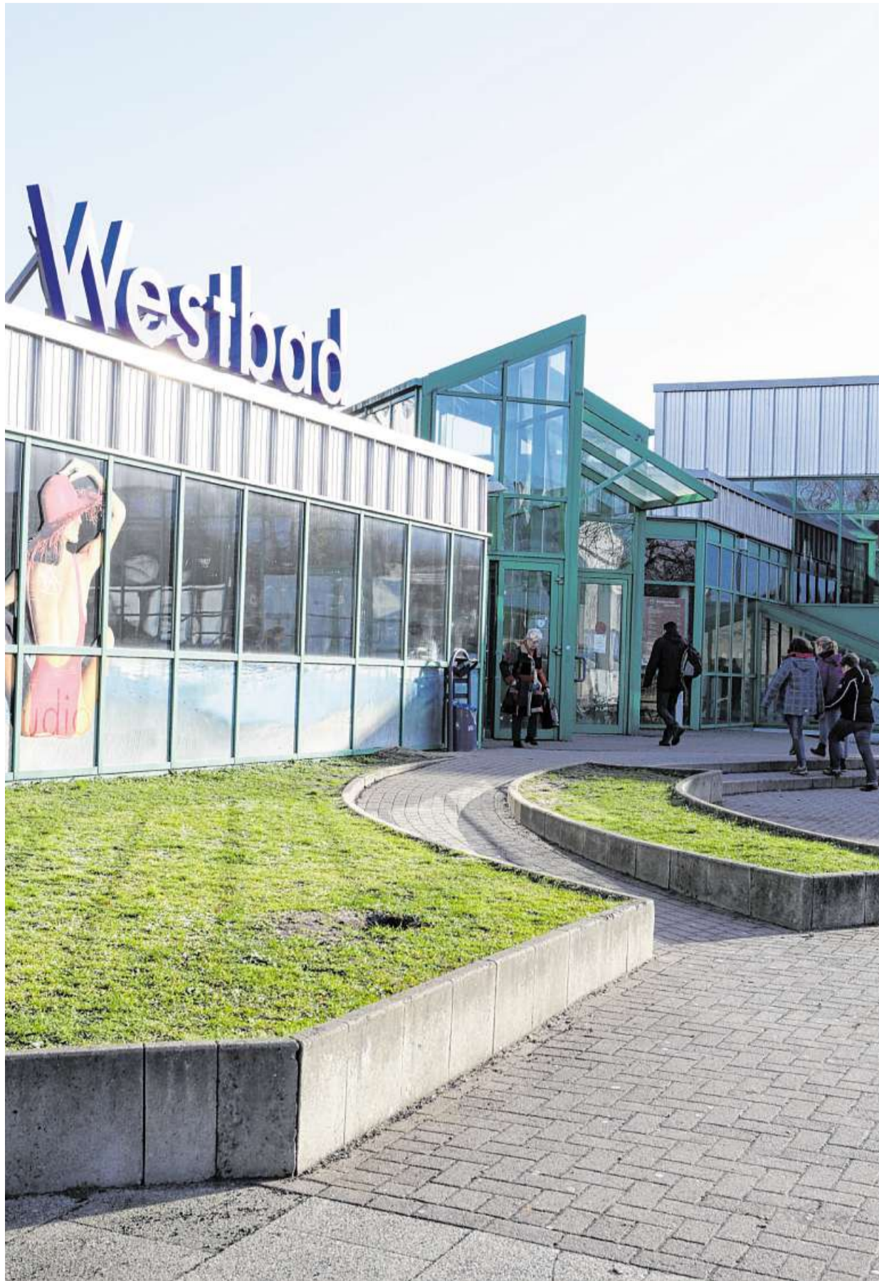
Der Charme der 1970er-Jahre im Walle Westbad bedeu- tet aus technischer Sicht, dass das Bad „akut von Ausfall bedroht“ ist, wie Bäderchefin Martina Baden jetzt in der Sportdeputation erklärte. Gleichwohl wird der geplante Neubau nach jetzi- gen Planungsstand erst ab Sommer 2020 starten können.
