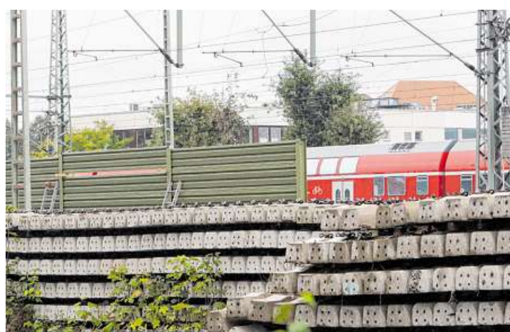
Die Wittenberger Straße in Walle (Foto) hat sie schon, nun bekommt sie auch die Stolzenauer Straße in Hastedt: eine von der Deutschen Bahn bezahlte Lärmschutzwand entlang der Bahntrasse. FOTO: GERBRACHT
