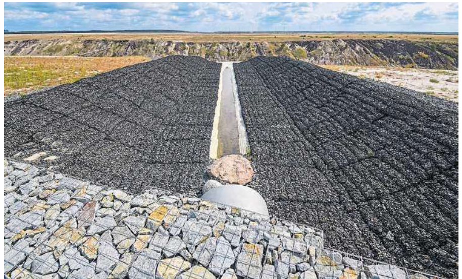
So sieht es nach der Braunkohle aus: Das neue Wasser-Einlaufbauwerk zur Flutung des ehemaligen Tagebaus Cottbus-Nord, aus der Grube soll der größte künstliche See Deutschlands mit etwa 19 Quadratkilometern Wasseroberfläche entstehen Foto: Patrick Pleul/dpa
