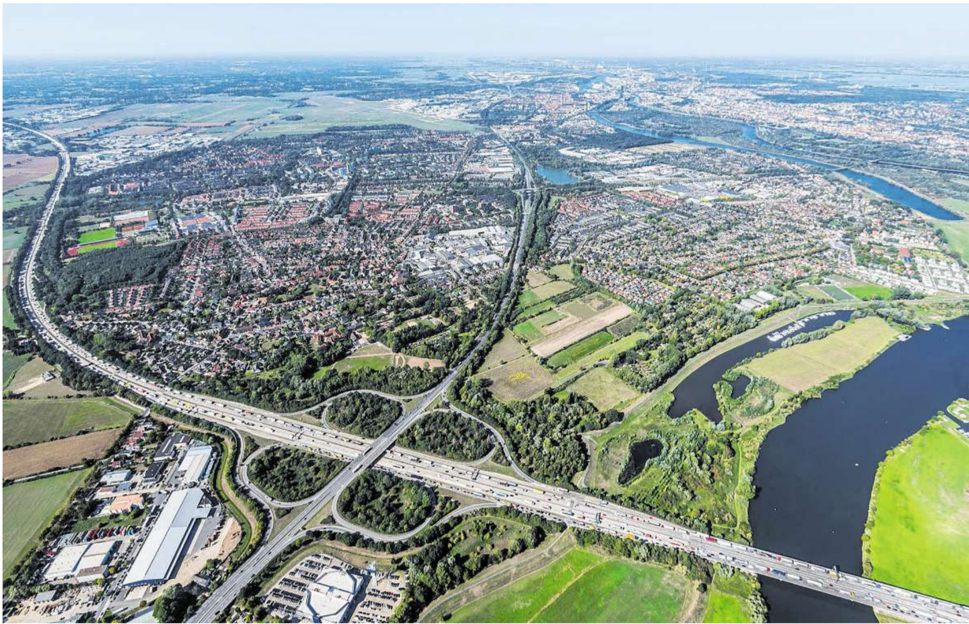
Das Amt für Straßen und Verkehr, das bislang für die Sanierung der Autobahnen (hier die A1-Abfahrt Arsten) zuständig ist, braucht eine neue Leitung.
